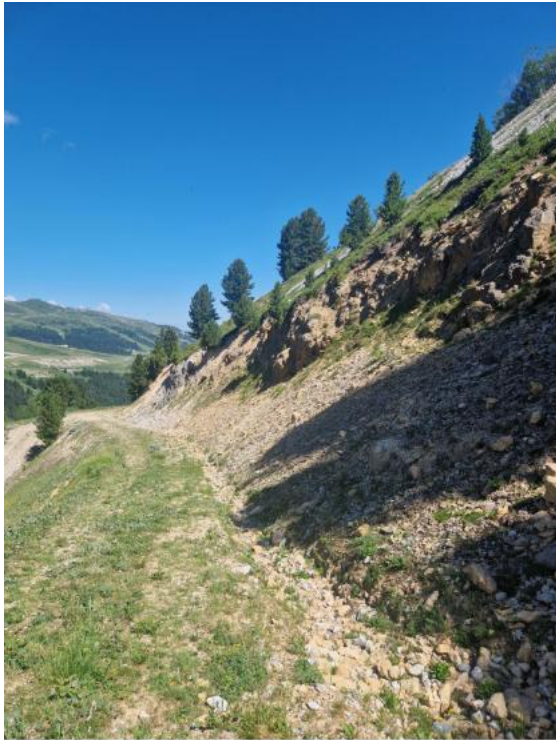
Figure 13 : Photographie du talus choisi pour expérimenter des techniques de génie végétal dans un objectif de stabilisation, avec une pente de 32^{\circ} , s'étendant sur 100\text{m}^2 .
