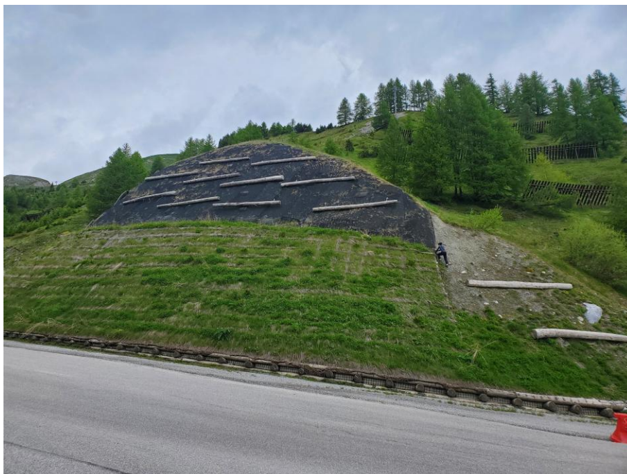
Figure 6 : Ouvrage de génie végétal avec du treillage bois à Tignes (73320). Source : Nicolas Fermon
