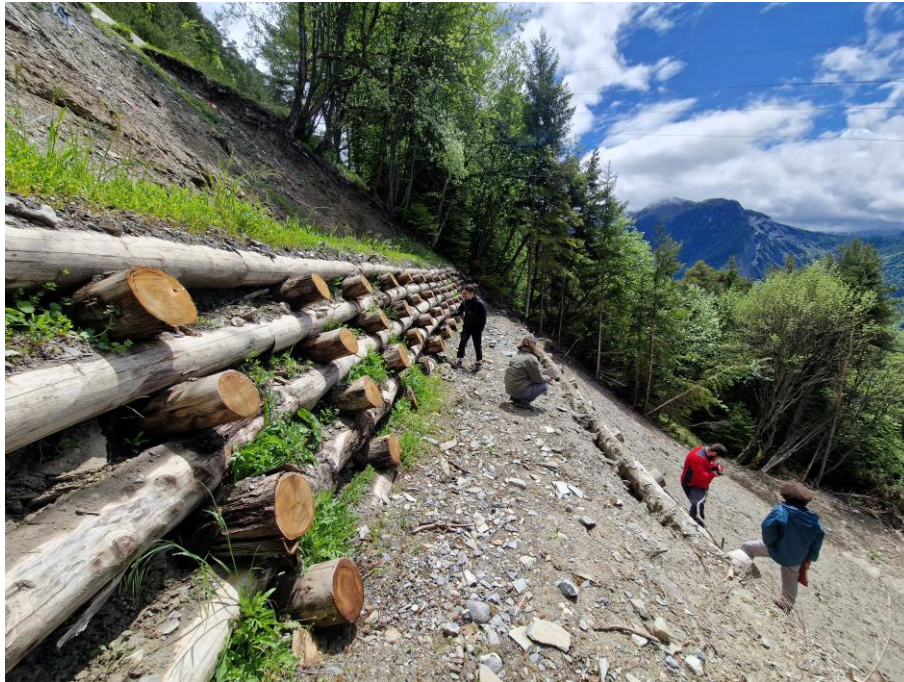
Figure 5 : Ouvrage de génie végétal avec des caissons végétalisés à Saint-Julien-Mont-Denis (73870). Photographie : Lény CALO'
