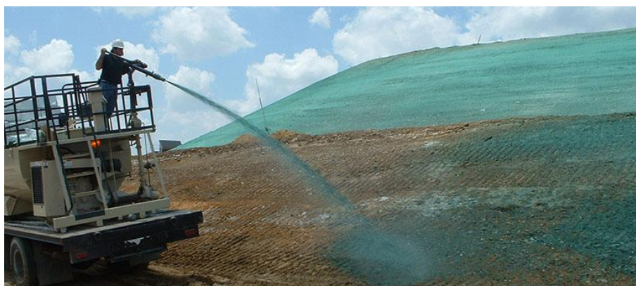
Figure 7 : Revégétalisation par une technique d'hydroseeding. 4
