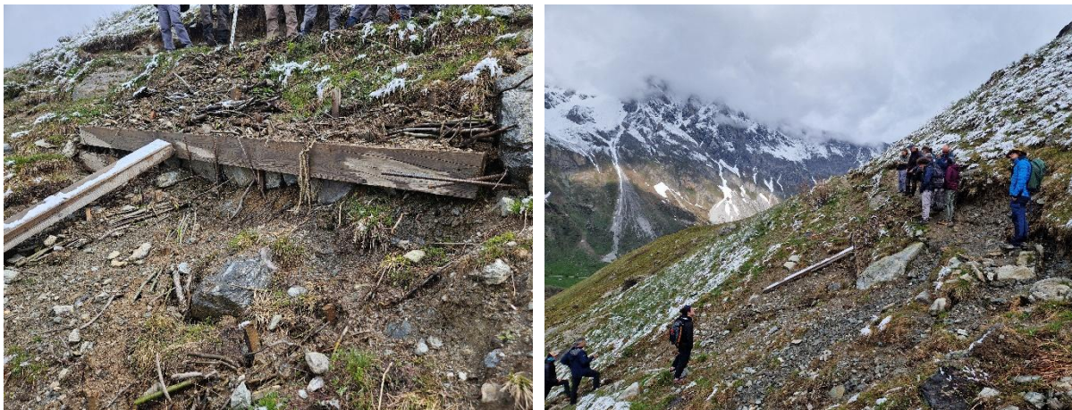
Figure 14 : Photographies du chantier de génie végétal sur le sentier de randonnée en cœur du parc national de la Vanoise
