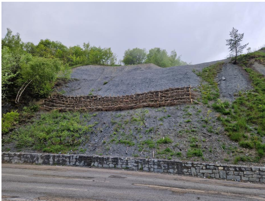
Figure 4 : Ouvrage de génie végétal avec du tressage à Valmeinier (73450). Photographie : Lény CALO'
