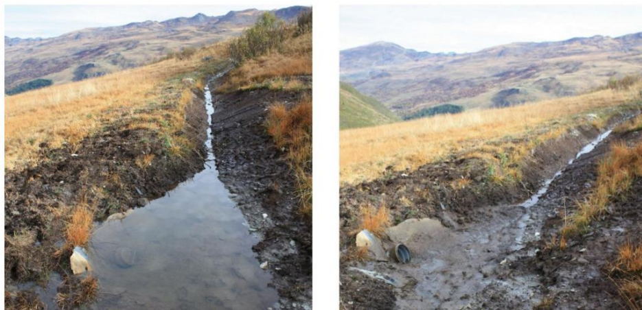
Figure 5 - Système de distribution de l'eau réalisés pour la zone humide des Enverses aux Ménuires (Crédits : Jérôme Porteret, source : Porteret et al., 2018)
